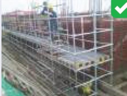
Pipa lantai memanjang pipa terpasang pada bangunan perancah minimal pada satu sisi bangunan perancah.
