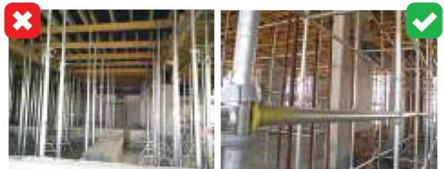
Pada bangunan perancah paling atas dipasang pagar, bagian atas pagar setinggi 110 cm dan bagian tengah pagar setinggi 6 cm bila digunakan untuk pelataran platform serta dilengkapi jaring sebagai pengaman pinggir lantai.
