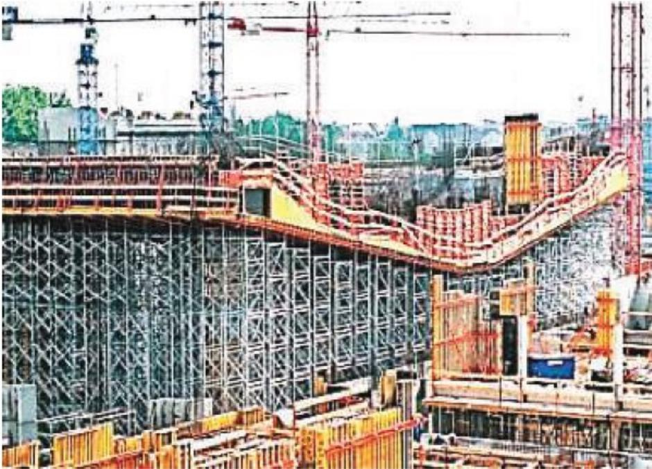
Perancah yang berfungsi sebagai penopang komponen struktur saat masa konstruksi.
